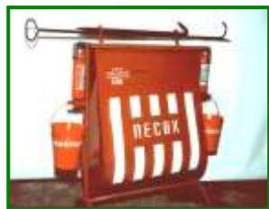
**Пожарный щит** должен иметь ящик с песком, пожарные ведра, багор, лопаты, огнетушители. Каждый огнетушитель должен иметь паспорт, а на корпусе должен быть указан его порядковый номер.
